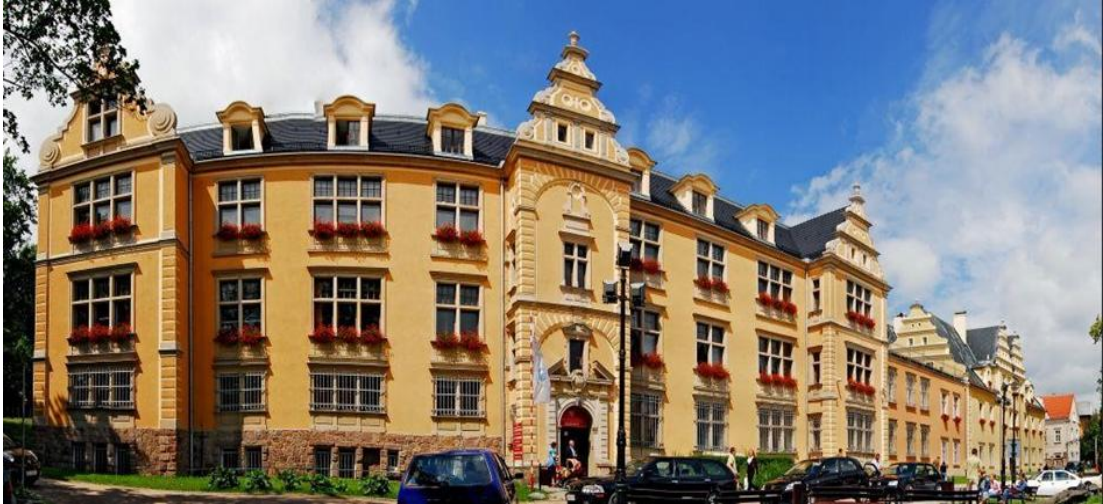
Rysunek 1. Budynek dydaktyczny przy ul. Zamkowej 4 (Budynek A)
