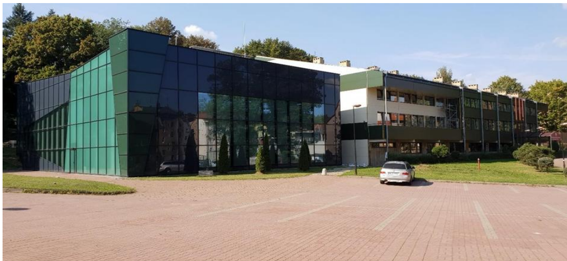
Rysunek 2. Budynek dydaktyczny przy ul. Piotra Skargi 14a (Budynek B)
